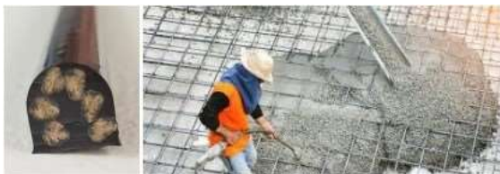
Figura 6.7 - Rebar de cânepă pentru construcții din cement
